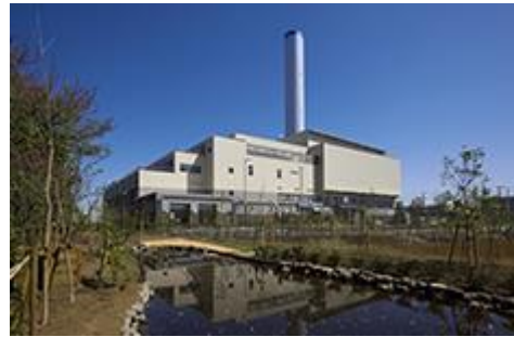
ふじみ衛生組合 HPより
