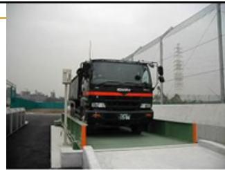
トラックスケール(計量所) 名古屋市HPより
