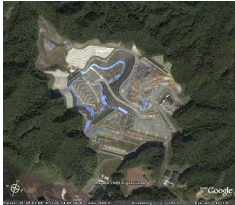
ニツ塚処分場（日ノ出町）建設工事費約500億円
